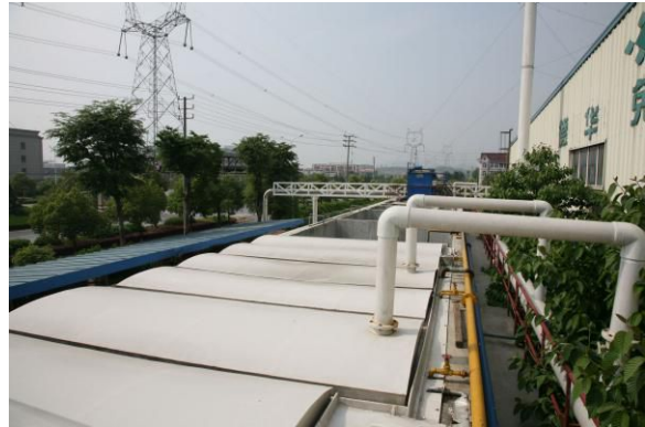
污水处理设备
